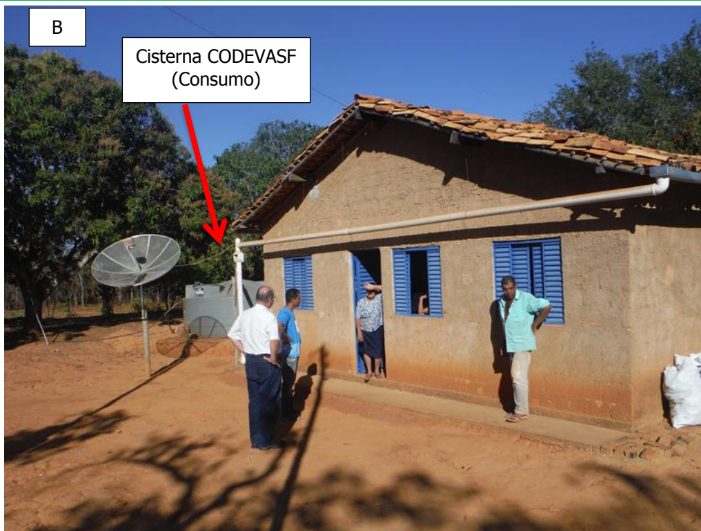
Figura 6.1 – (A) Em 1º plano o Poço Escavado, ao fundo a Cisterna CODEVASF e (B) Casa com detalhe do sistema de captação de água de chuva.
